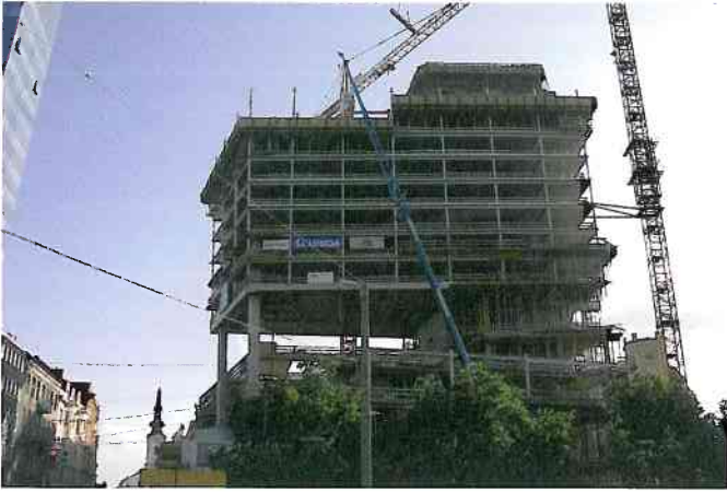
Bild 15. Regelgeschossmontage Fig. 15. Typical floor erection
