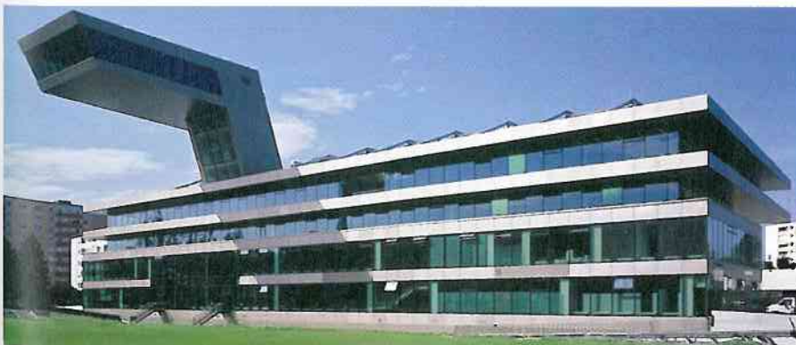
Bild 1. Ostseitig auskragende Panoramabar
