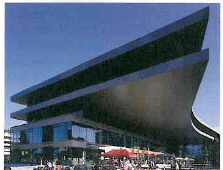
Bild 2. Westseitig auskragendes Bibliotheksgeschoss (Fotos: UBM Realitätenentwicklung AG)
