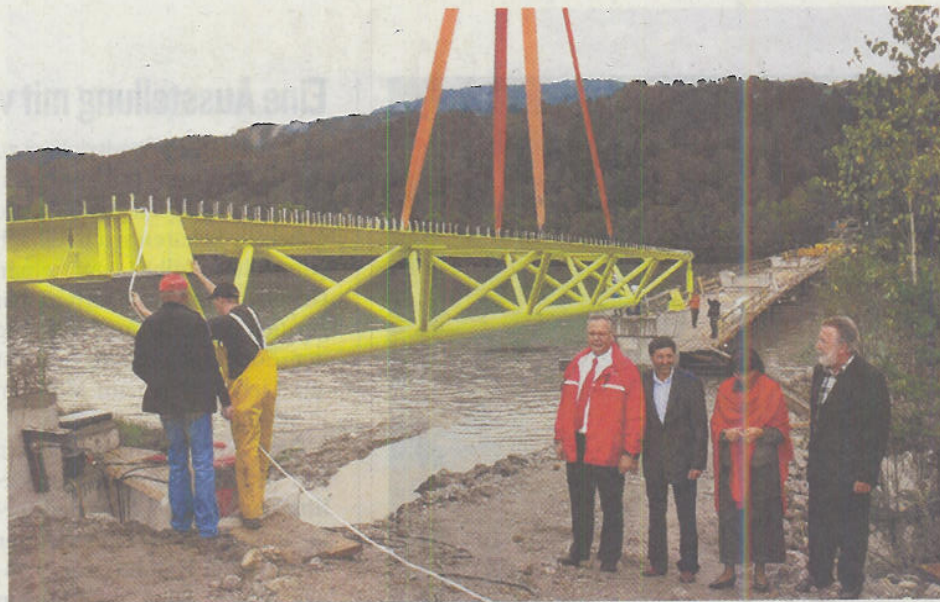
Bei der ersten Brückeneinhebung dabei waren Landesrat Rohr und Bürgermeister Johann Obiltschnig KRALL
