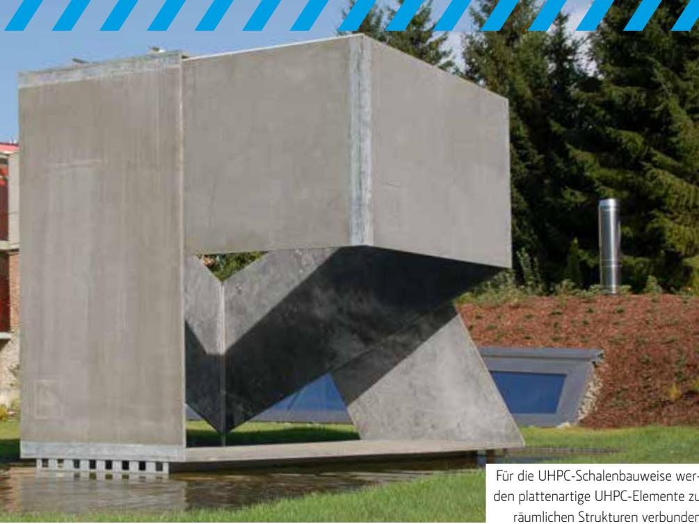
Für die UHPC-Schalbauweise werden plattenartige UHPC-Elemente zu räumlichen Strukturen verbunden
