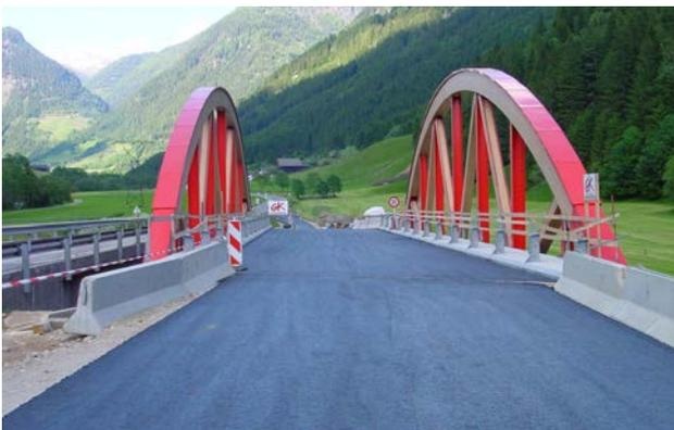
ßend über die neue Brücke umgeleitet. Die alte, bestehende Brücke wird sodann abgetragen, und danach werden die Widerlager auf Pfählen errichtet. Abschließend wird die neu errichtete Brücke während einer Nachtsperre in die bestehende Straßenachse quer verschoben, sodass sie bereits in der Früh für den Verkehr freigegeben werden kann.
