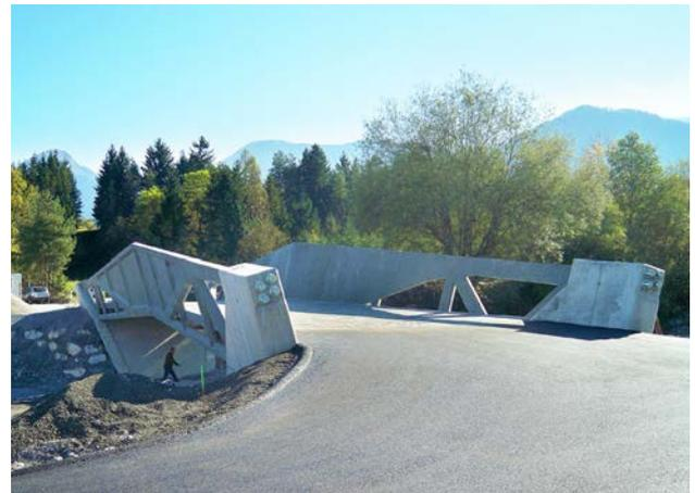
Durch die räumliche Anordnung der Fertigteile mit einem Knick in Brückenmitte konnte der Obergurt unter Ausnutzung der geometrischen Steifigkeit mit einer Obergurtbreite von lediglich 15,5 cm ausgeführt werden. Die Scheibendicke des restlichen UHPC-Fertigteiles konnte auf 6 cm bemessen werden. Die Fahrbahnplatte wurde aus selbsttragenden Halbfertigteilen mit Aufbeton aus Hochleistungsbeton hergestellt, diese Konstruktion bedarf keiner herkömmlichen Brückenabdichtung.
