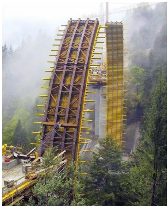
Die Brücke wurde als Stahlbetonbrücke mit geraden Bogen-Bogenstützweite 70m, Gesamtstützweite 135m- und einer Gesamthöhe von 60m über Grund errichtet. Das aufgeständerte Tragwerk weist einen Plattenquerschnitt auf und wird als Durchlaufträger mit 10 Feldern über die Stützen der Vorländer und den Stützen des Bogens geführt. Der Bogen wurde mit einer Stahlterappe für Revisionszwecke begehbar gemacht.
