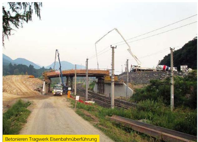
Betonieren Tragwerk Eisenbahnüberführung
